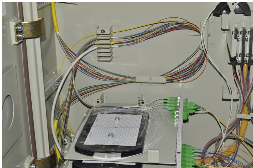
Рис.5 Ввод и выкладка волокон магистрального кабеля
