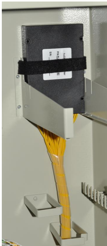
Рис.2 Установка разветвителя в корпусе
