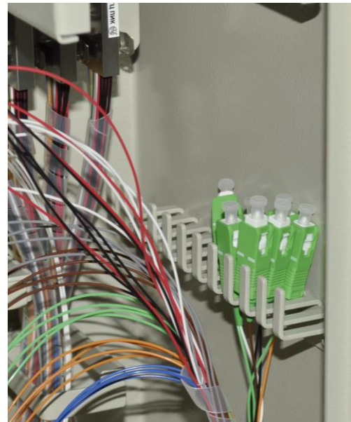
Рис.3 Швеллер с неиспользуемыми вилками выходов разветвителей
